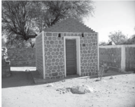
Figura 12: Bóveda Cementerio La Ciénaga
